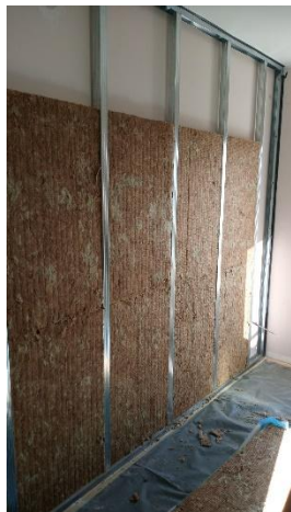
Postavljanje konstrukcije i vune
