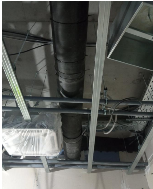
Oblaganje cevi zvučnom izolacijom AIT PR 3.5
