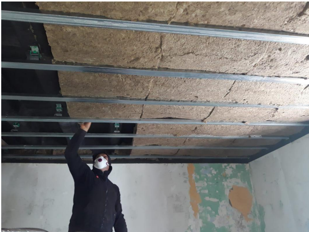
Postavljanje akustičkih visilica, konstrukcije i izolacije
