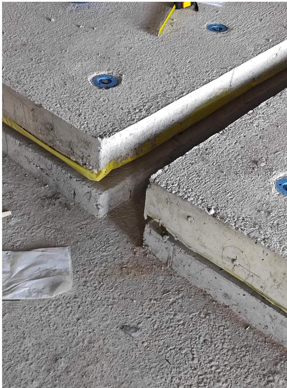
Izgled plivajućeg poda po završenoj montaži opruga
