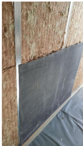
Postavljanje zvučne membrane
