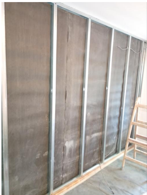
Primena zvučne izolacije AIT PR 3.5 u sistemima zidnih obloga
