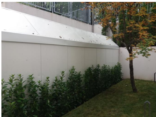
Kombinacija metalnih panela sa zelenim zidom
