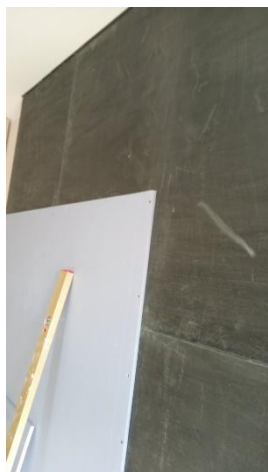
Postavljanje panela ZIPS dB
