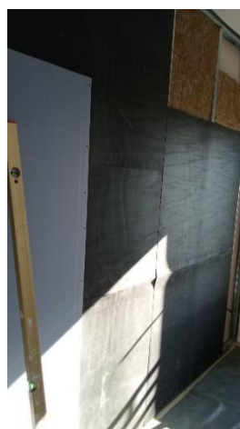
Postavljanje panela ZIPS dB
