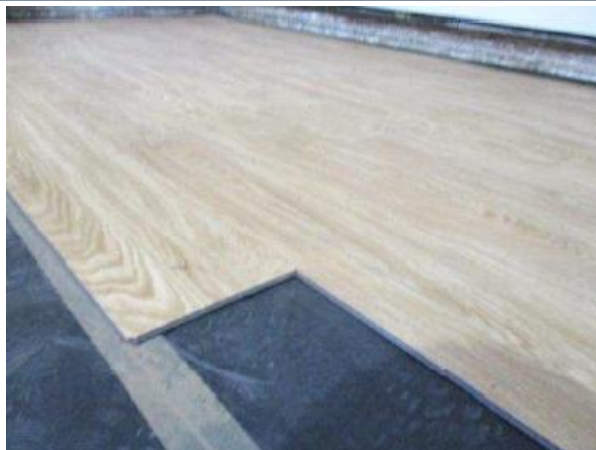
Laminat postavljen preko izolacije Parquemix
