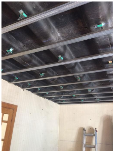
Zvučna izolacija AIT PR 3.5 u plafonskim sistemima
