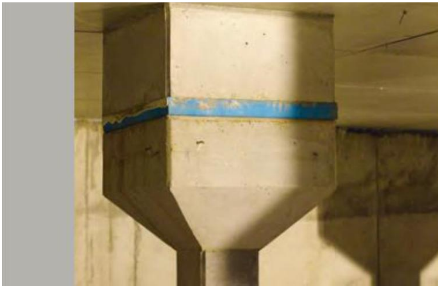
Primer tačkastog strukturnog odvajanja pomoću Sylodina
