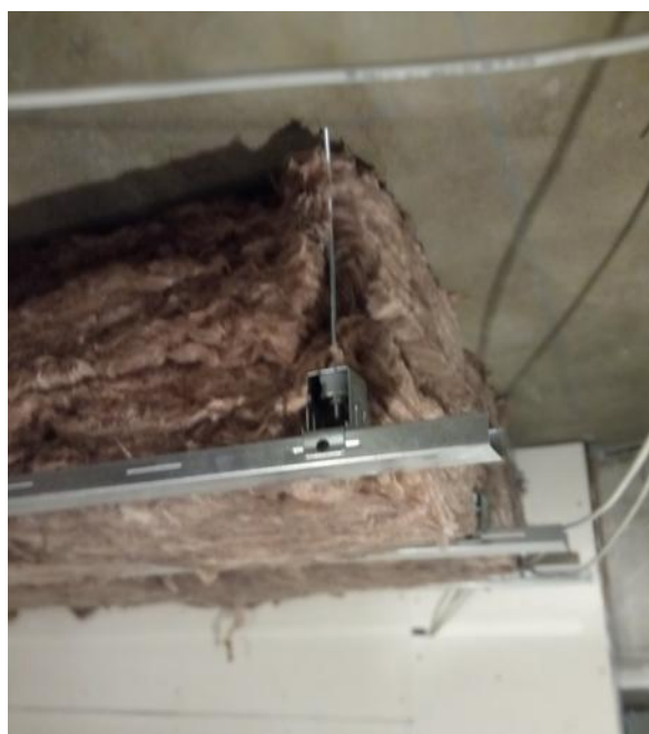
Primena Akustičke visilice Akustik Super T60 A-45 Sh u spuštenim plafonima
