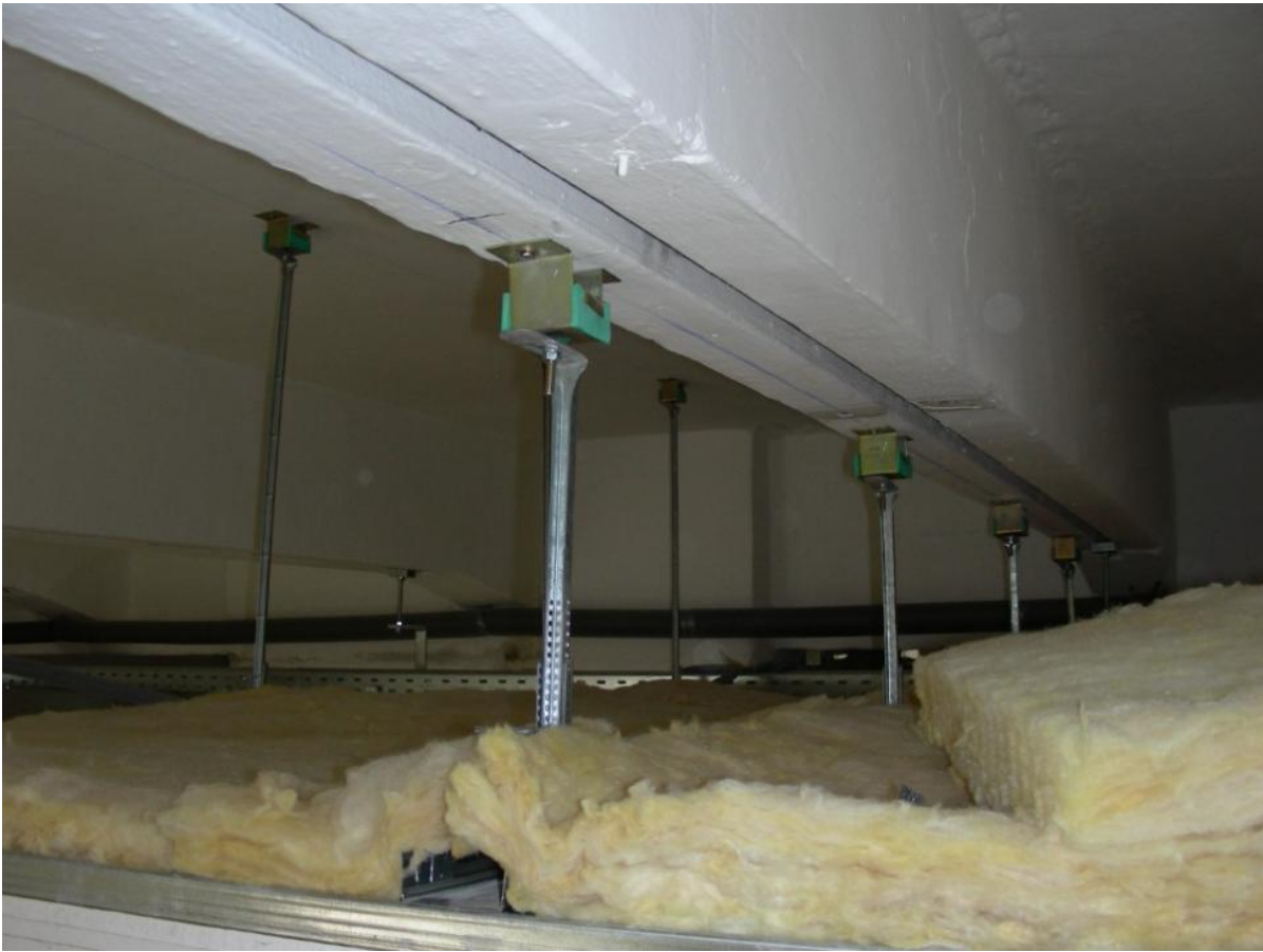
Primena visilica Akustik 1 + Sylomer u kombinaciji sa nonijus visilicama i CD profilima
