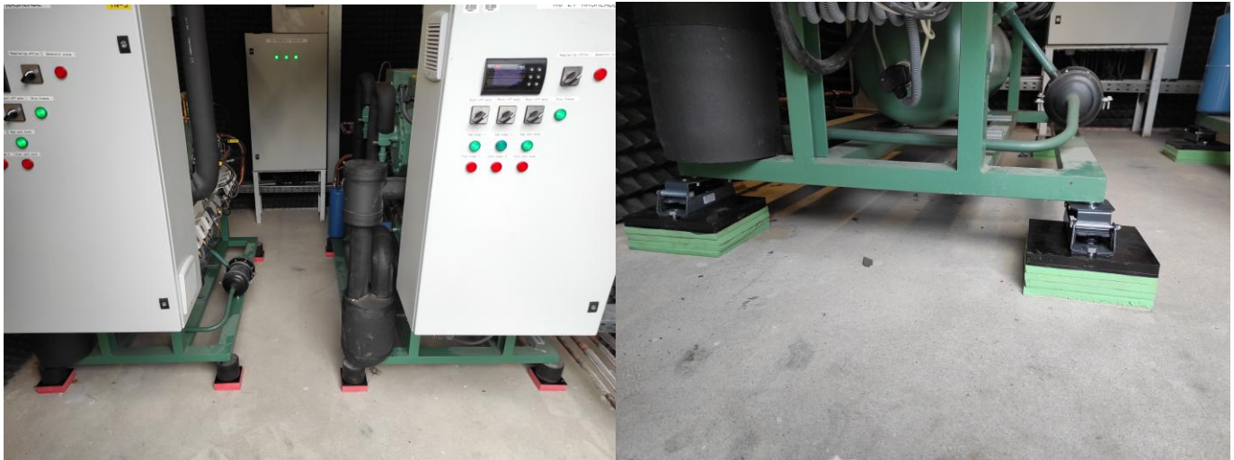
Primena Sylomera i Sylodina u rešenjima zaštite od vibracija uređaja i opreme
