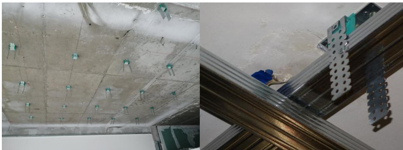
Primena Akustičkog distancera EP 700 + Sylomer 30 u spuštenim plafonima
