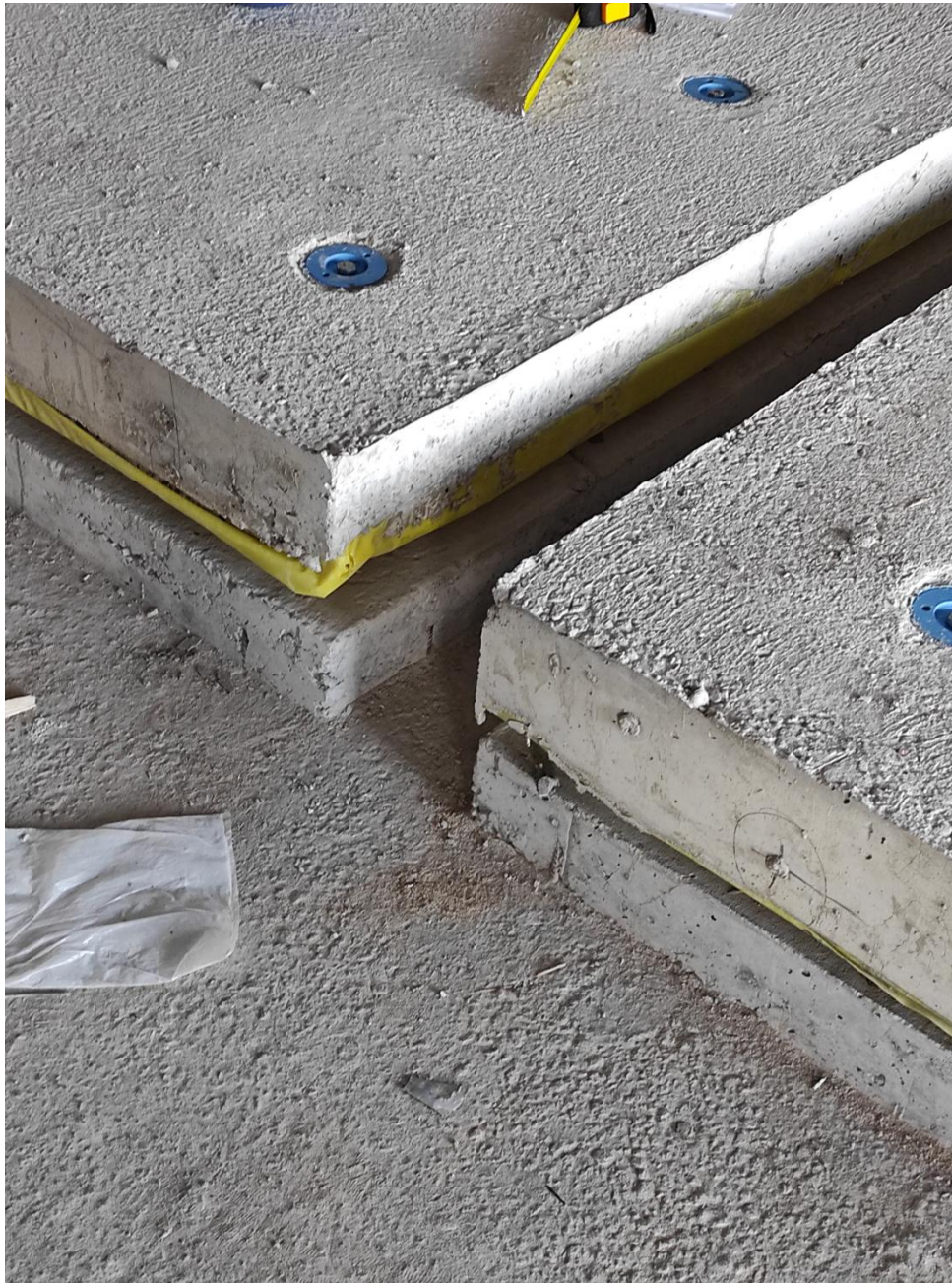
Izgled plivajućeg poda po završenoj montaži opruga
