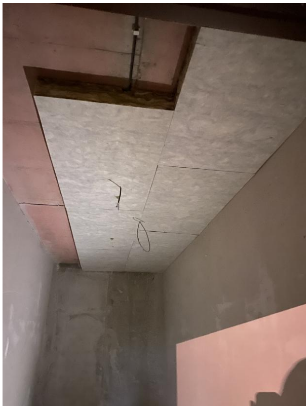
Primena apsorbera zvuka URSA Tectonic u beloj boji lepljenjem direktno na plafone i zidove
