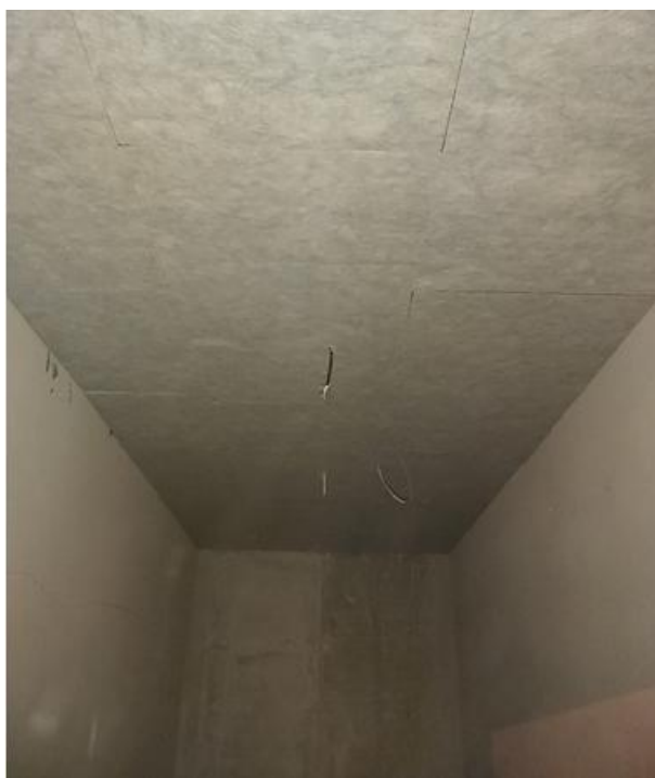
Primena apsorbera zvuka URSA Tectonic u beloj boji lepljenjem direktno na plafone i zidove
