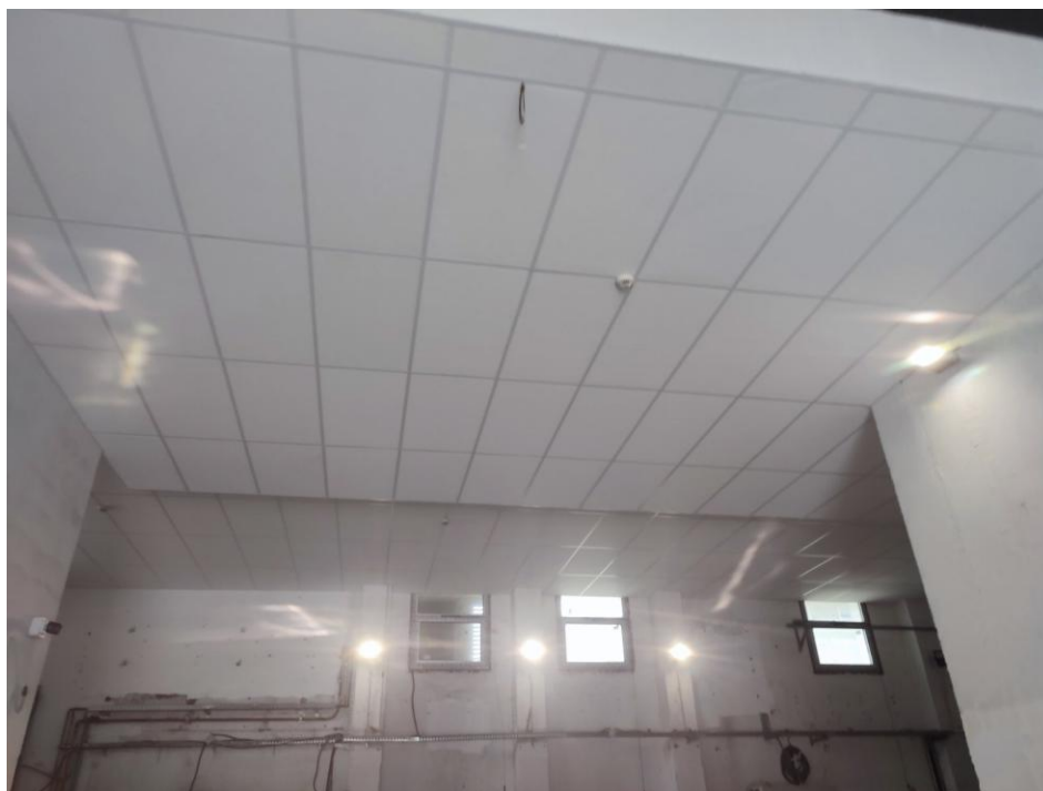
Primena panela Ecophon Industry Modus 600 x 1200 u okviru modularne vidne konstrukcije
