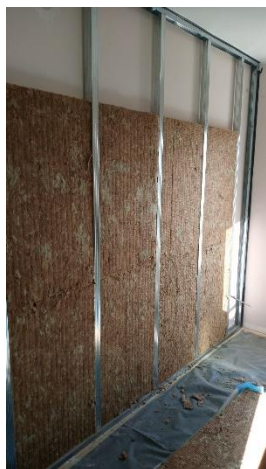
Postavljanje konstrukcije i vune
