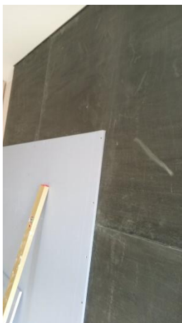
Postavljanje panela ZIPS dB
