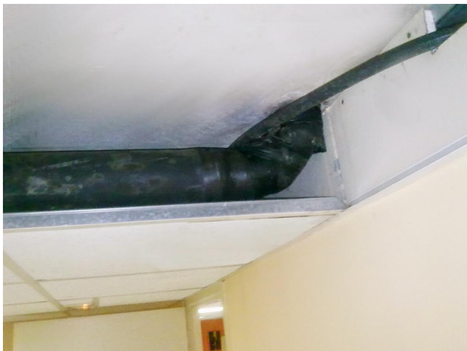
Oblaganje cevi zvučnom izolacijom AIT PR 3.5
