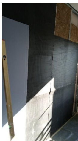
Postavljanje panela ZIPS dB
