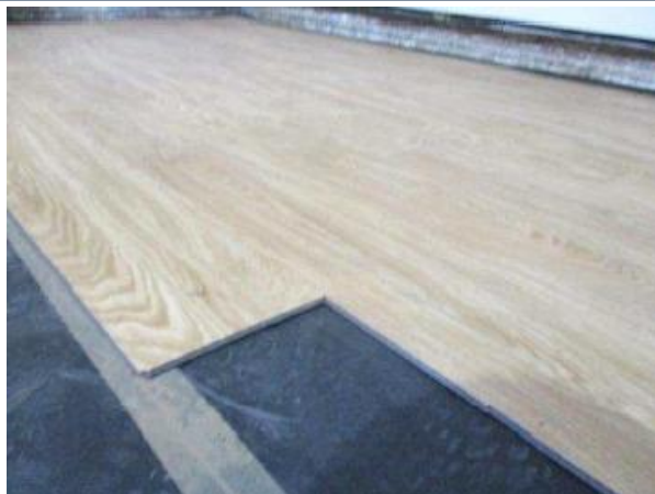
Laminat postavljen preko izolacije Parquemix
