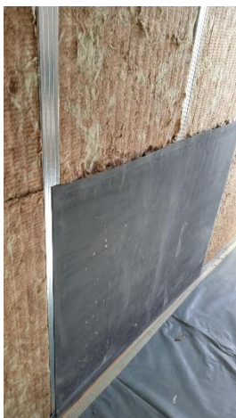
Postavljanje zvučne membrane
