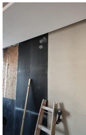
Lepljenje trake na spojevima membrane
