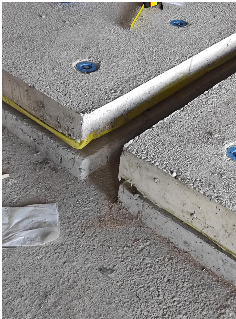
Izgled plivajućeg poda po završenoj montaži opruga
