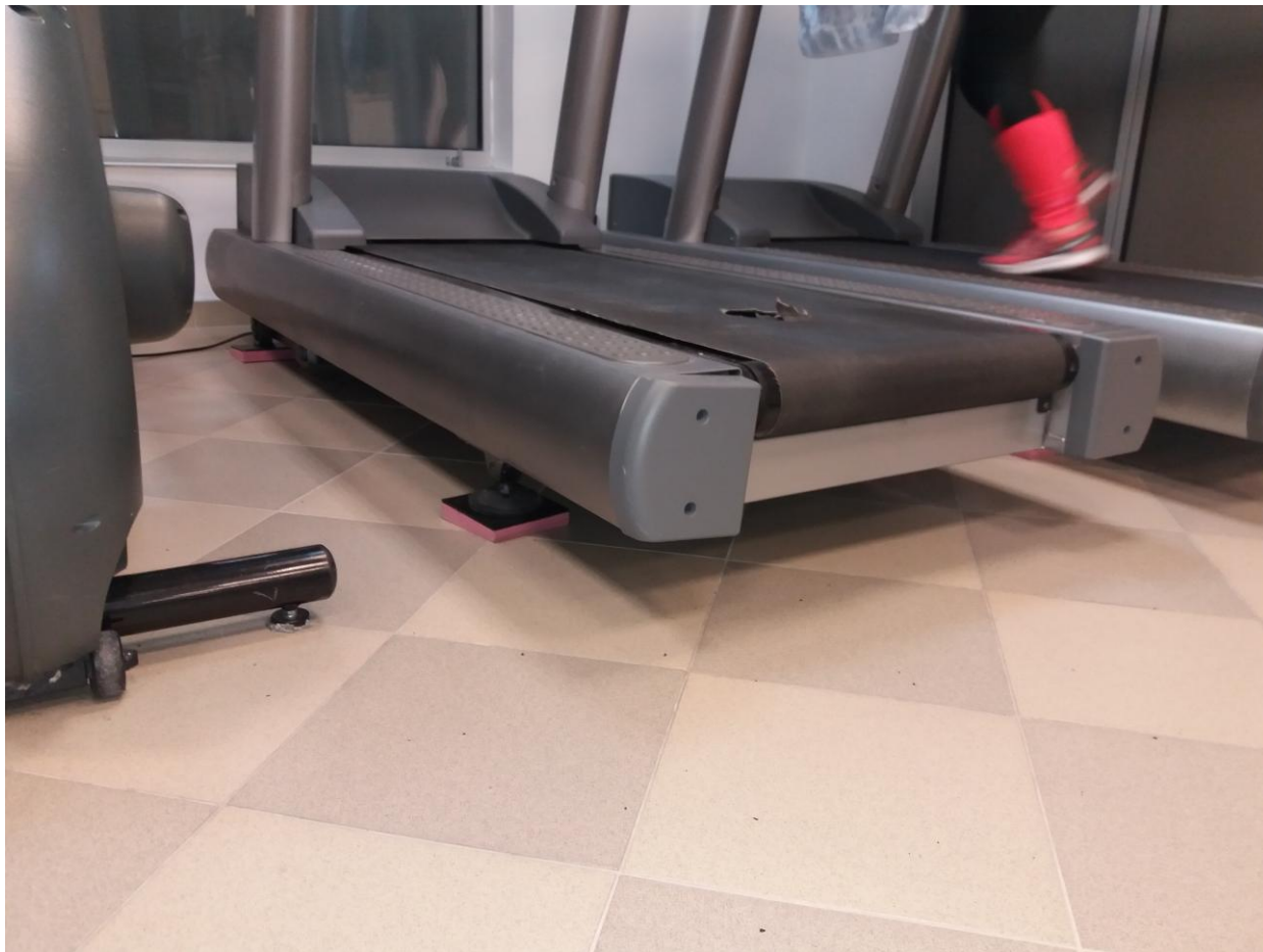
Primena Sylomera i Sylodina u rešenjima zaštite od vibracija u teretanama i Fitnes centrima
