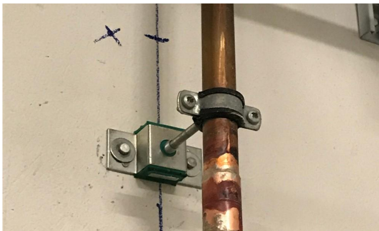
Primena elastične spojnice EP + Sylomer
