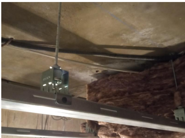
Primena Akustičke visilice Akustik Super T60 A-45 Sh u spuštenim plafonima
