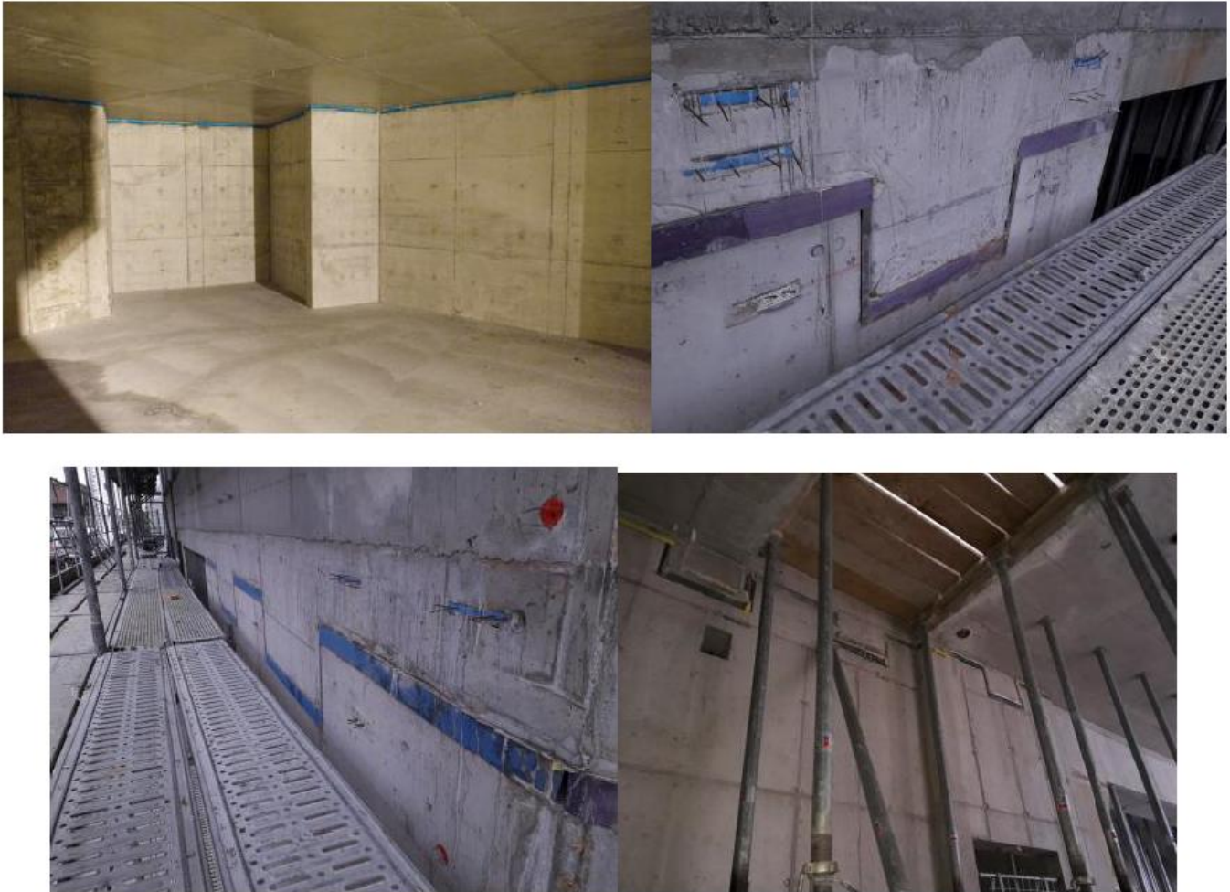
Principi tačkastog i trakastog elastičnog odvajanja objekta
