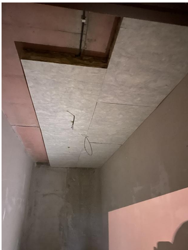
Primena apsorbera zvuka URSA Tectonic u beloј boјi lepljenjem direktno na plafone i zidove
