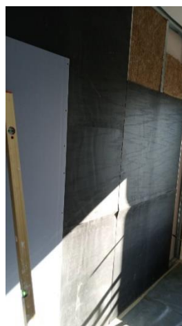
Postavljanje panela ZIPS dB
