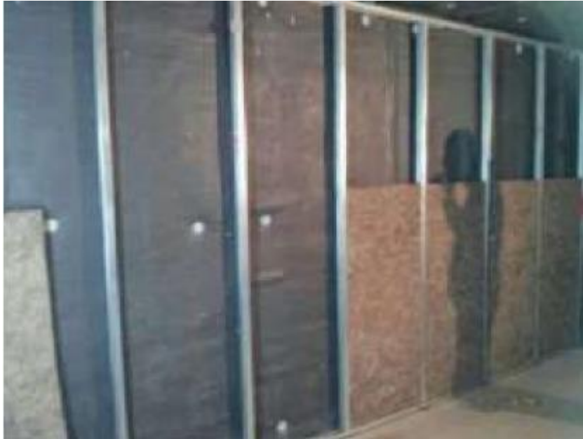
Primena zvučne izolacije AIT PR 3.5 u sistemima zidnih obloga
