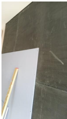
Postavljanje panela ZIPS dB
