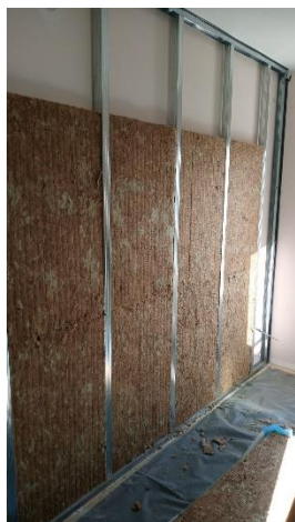
Postavljanje konstrukcije i vune
