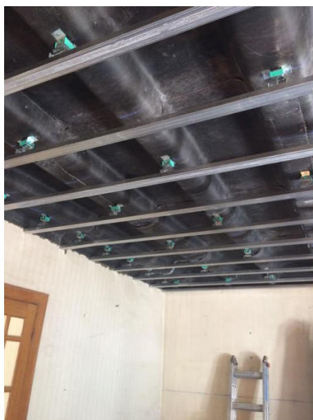
Zvučna izolacija AIT PR 3.5 u plafonskim sistemima
