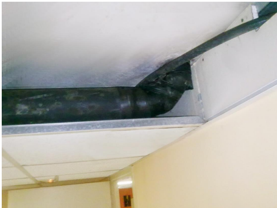
Oblaganje cevi zvučnom izolacijom AIT PR 3.5
