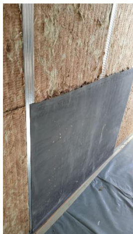
Postavljanje zvučne membrane
