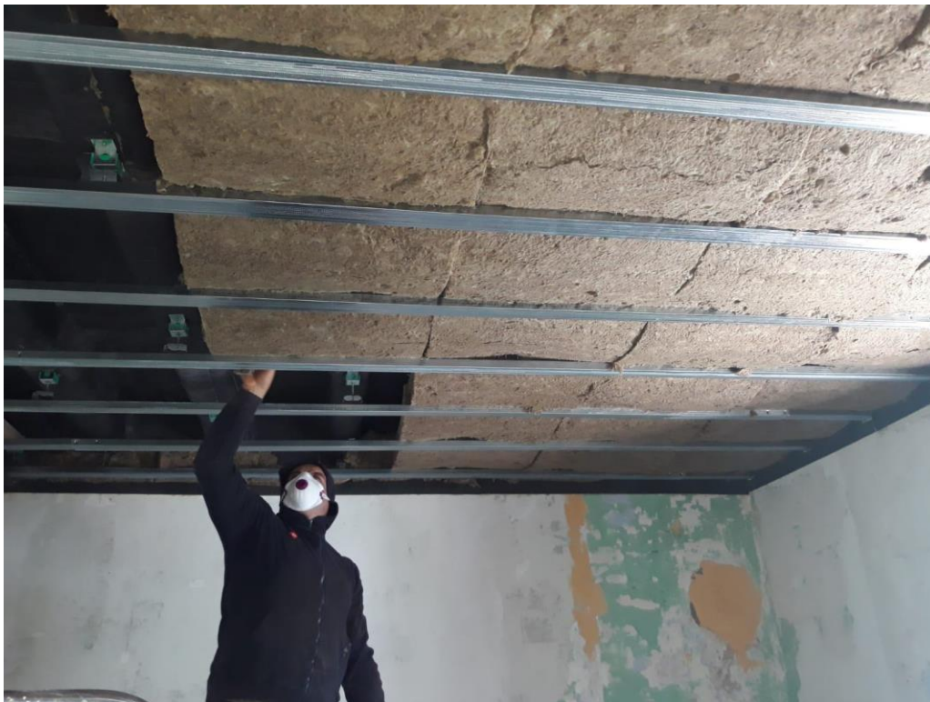
Postavljanje akustičkih visilica, konstrukcije i izolacije
