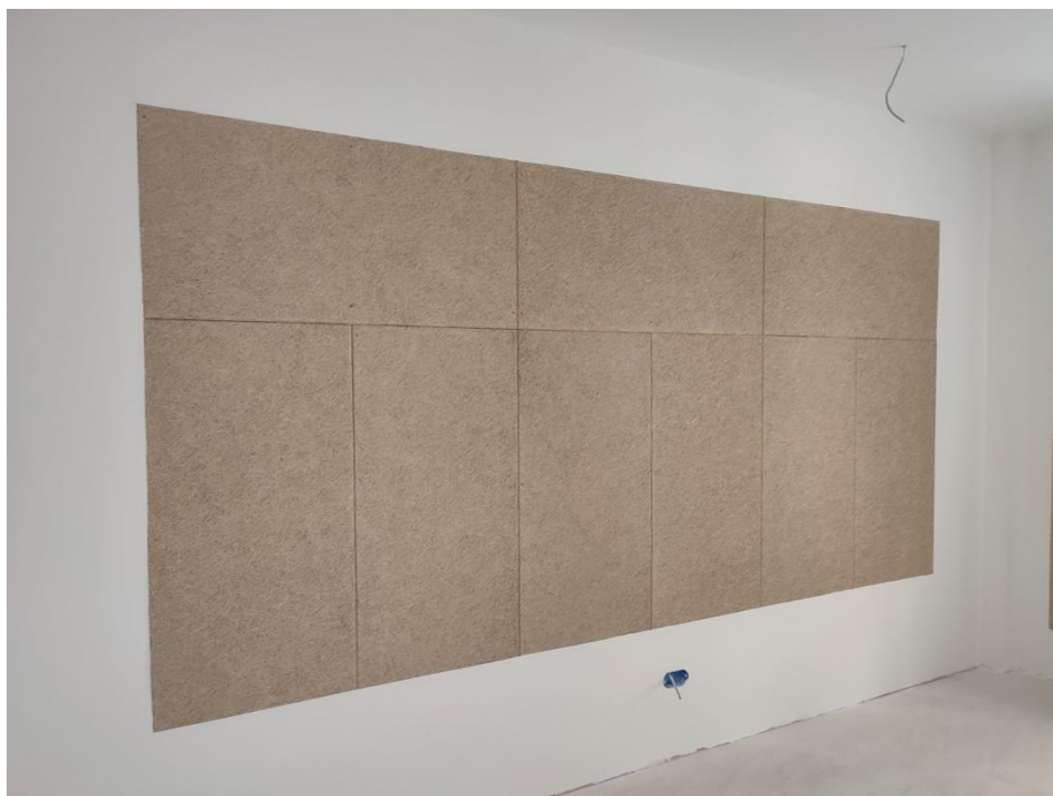
Primena Apsorpcionih ploča Heradesign 600x1200mm u kombinaciji sa oblogom zida od gipsa
