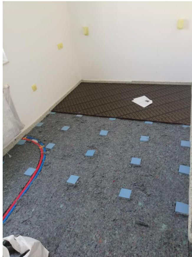
**Kod sistema poda sa stopicama PBE** - postavljaju se istovetni elementi kao i u varijanti sistema Floor Block, s tim što se sada ne postavljaju metalni UW profili već se podne ploče postavljaju direktno preko stopica **PBE** dimenzija 100 x 100 x 25mm bez konstrukcije.
