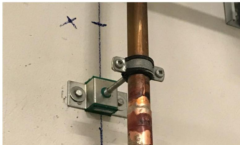
Primena elastične spojnice EP + Sylomer
