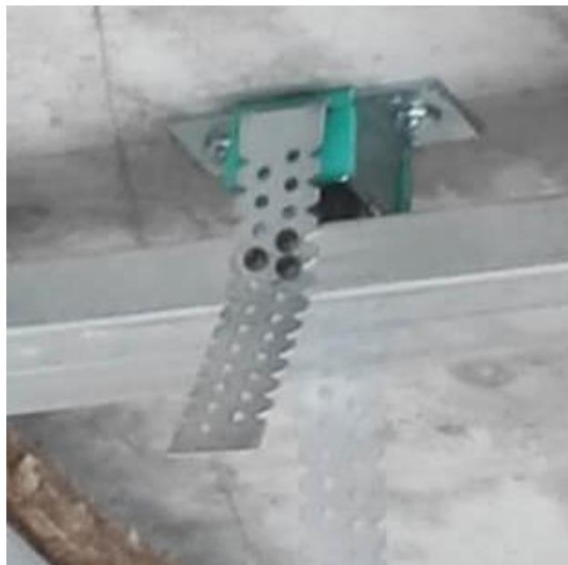
Spušteni plafoni za zvučnu izolaciju su obično masivniji i teži po kvadratu površine od klasičnih. Zbog toga akustički distancer treba povezati za CD profil sa većim brojem šrafova kao na gornjoj fotografiji.
