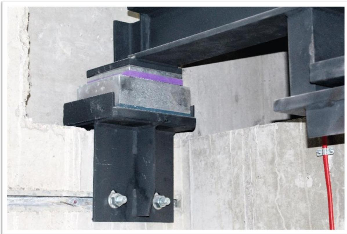
Primer strukturnog odvajanja metalne konstrukcije na koju se povezuje motor lifta
