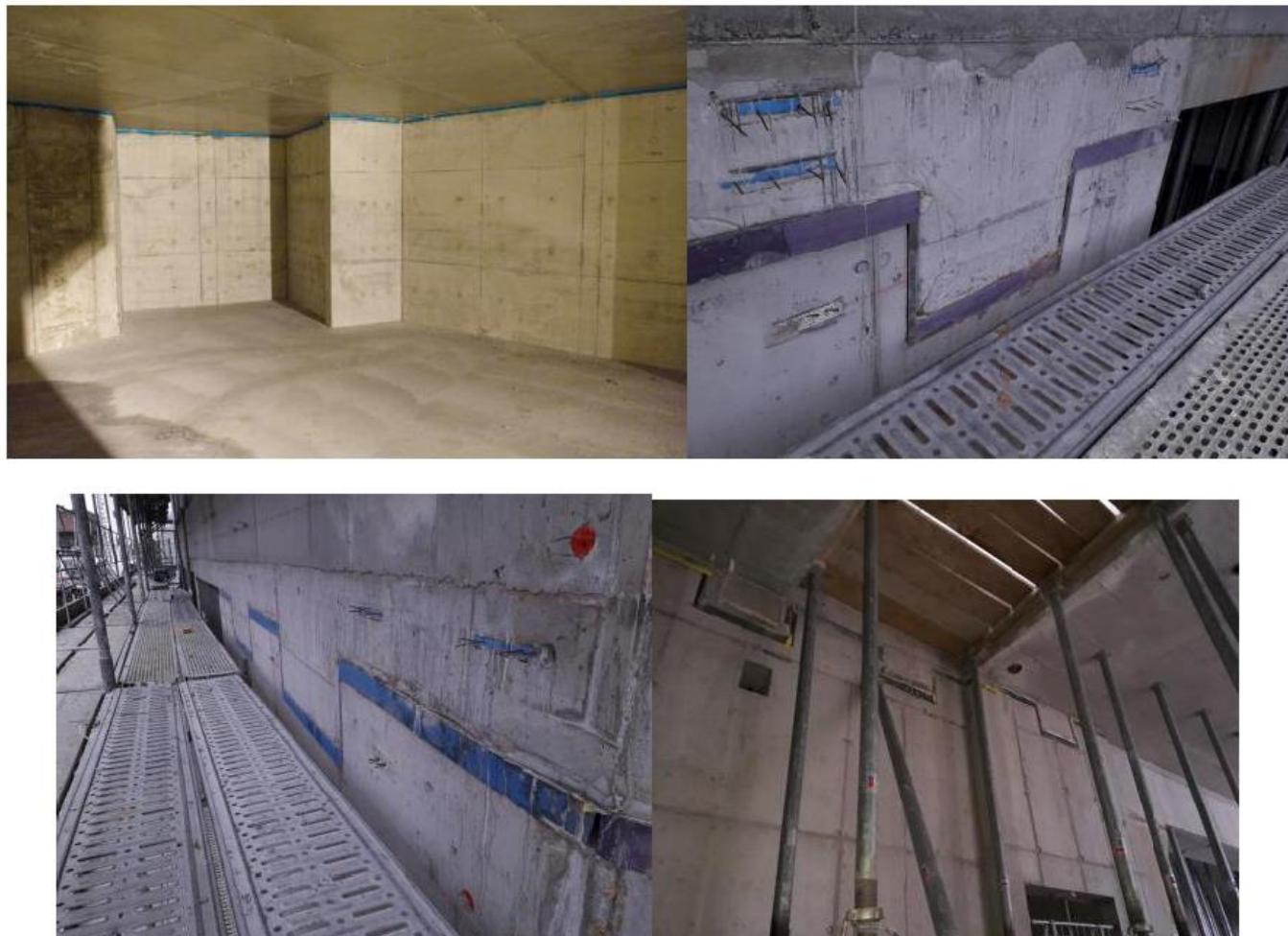
Principi tačkastog i trakastog elastičnog odvajanja objekta
