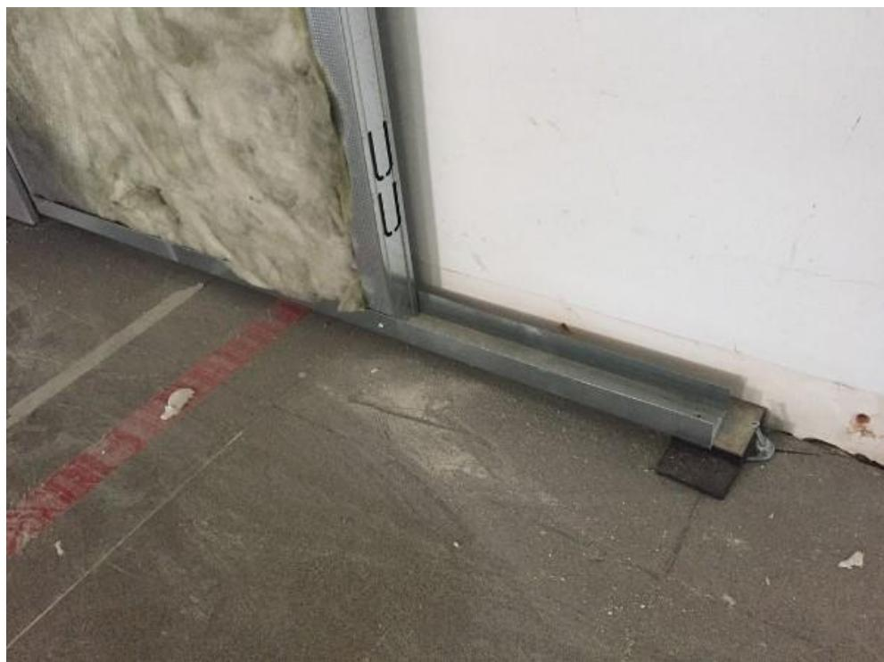
Primena elatičnih oslonaca E.P. 500 u lakinim pregradnim sistemima
