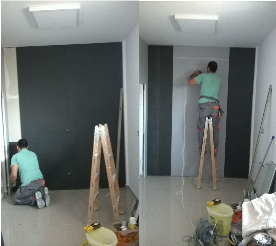
Postavljanje zvučne membrane Lamix izmedju dve gips ploče
