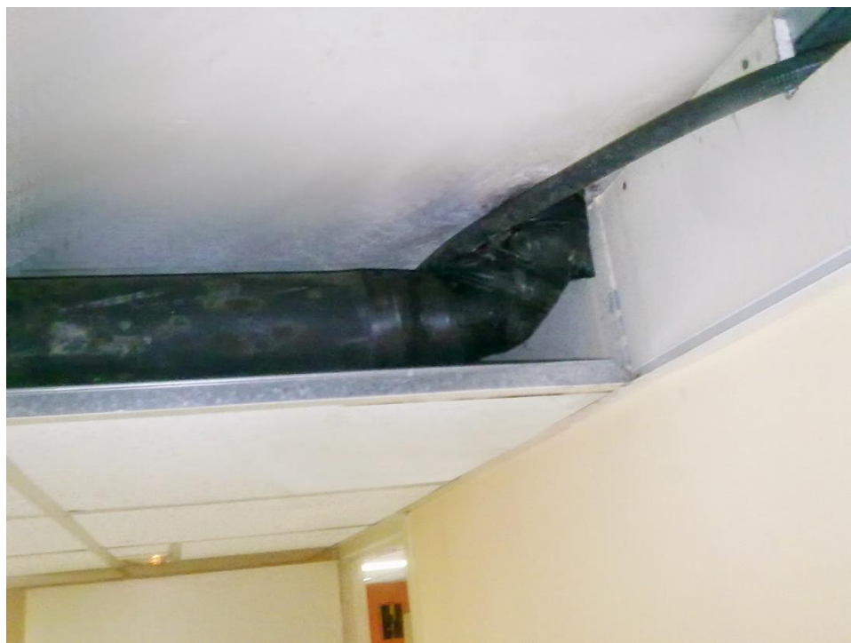
Oblaganje cevi zvučnom izolacijom AIT PR 3.5
