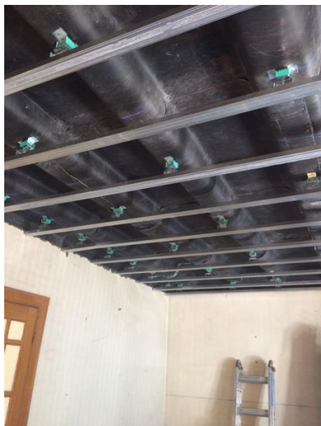
Zvučna izolacija AIT PR 3.5 u plafonskim sistemima
