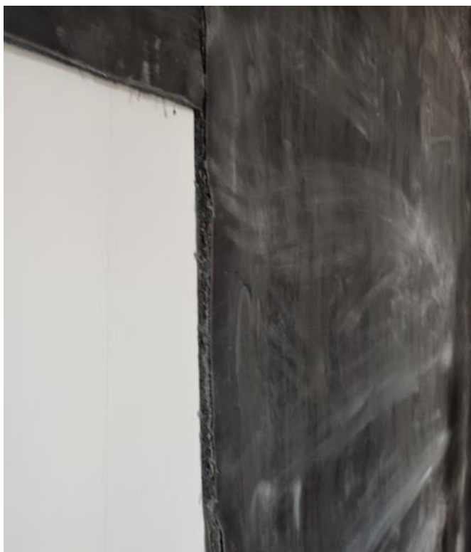
Popravka zvučne izolacije postojećeg zida membranom AIT PR 3.5
