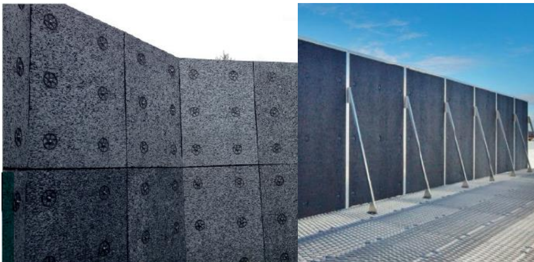
Primena materijala Stratocell Whisper kod izrade zvučnih barijera
