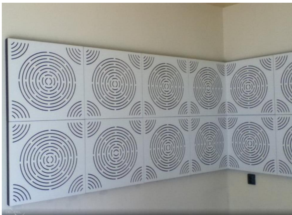
Primer ugradnje Circulo panela
