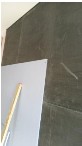
Postavljanje panela ZIPS dB
