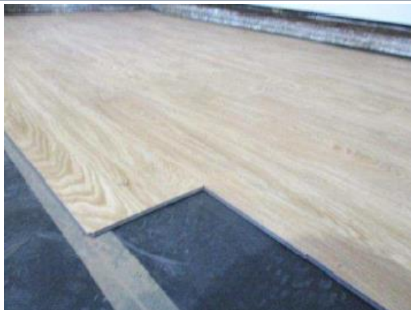
Laminat postavljen preko izolacije Parquemix
