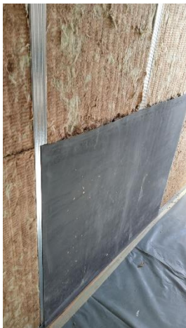
Postavljanje zvučne membrane
