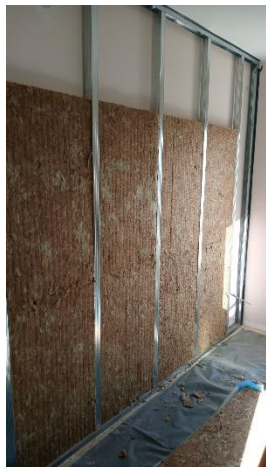
Postavljanje konstrukcije i vune
