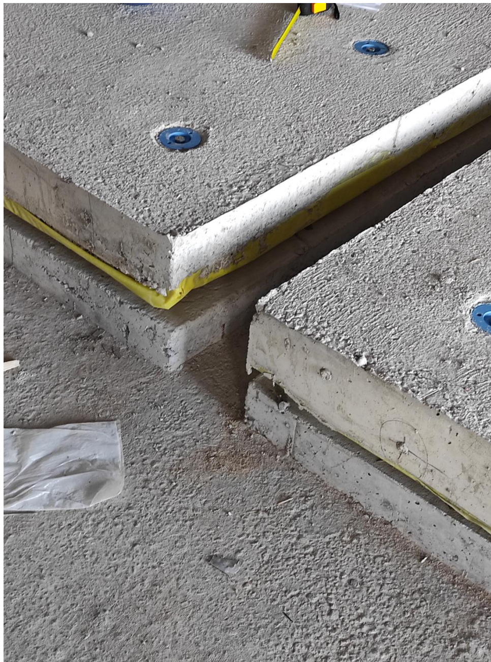
Izgled plivajućeg poda po završenoj montaži opruga
