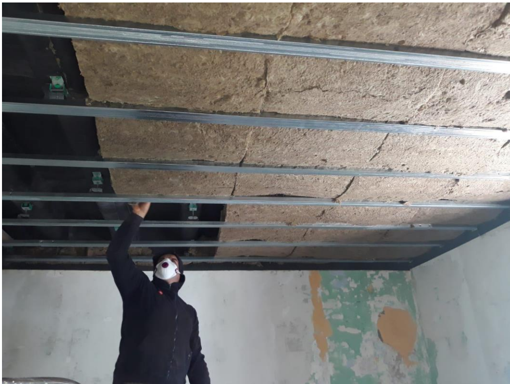
Postavljanje akustičkih visilica, konstrukcije i izolacije
