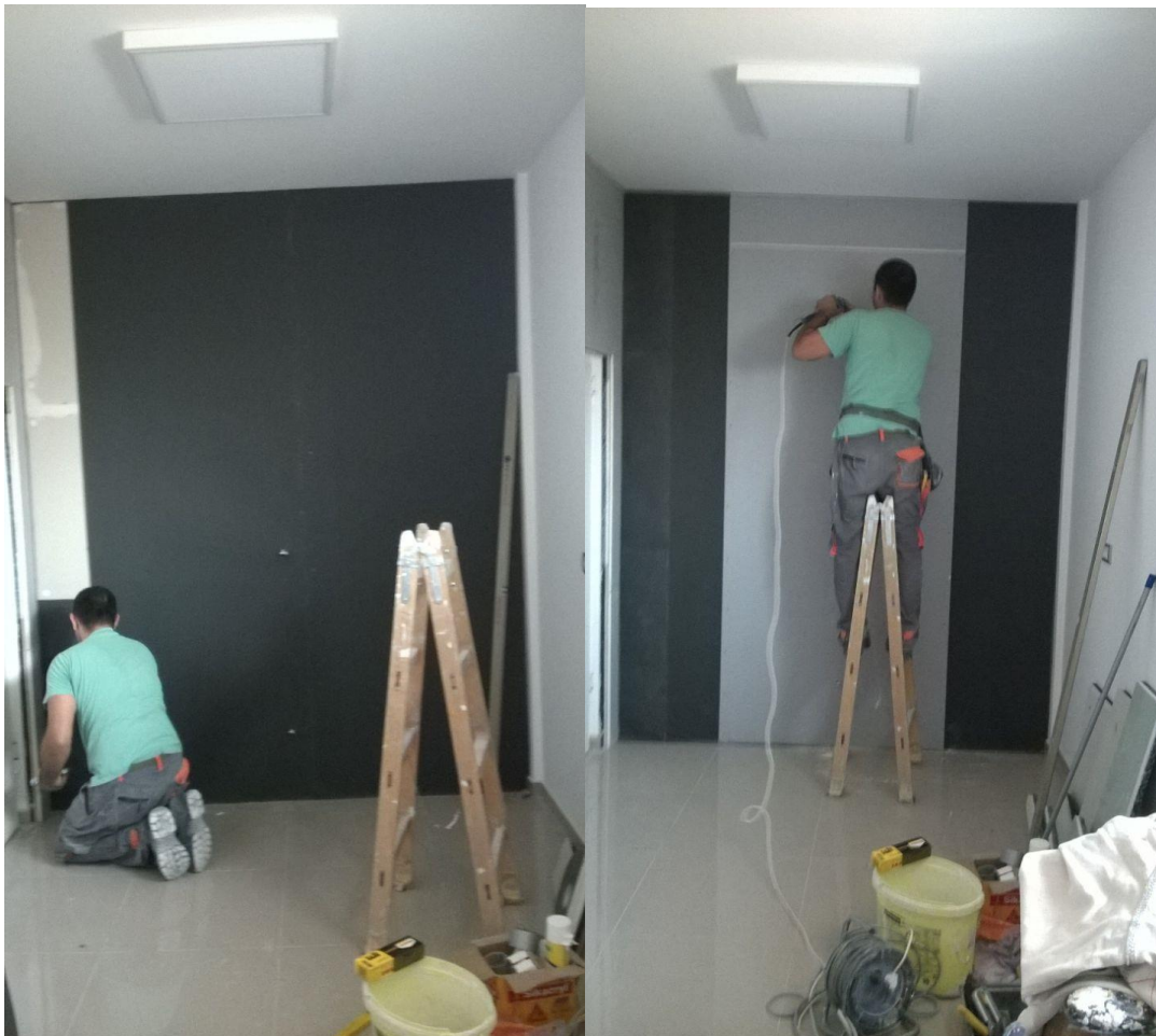
Postavljanje zvučne membrane Lamix između dve gips ploče
