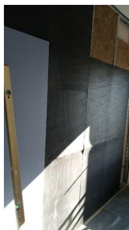
Postavljanje panela ZIPS dB
