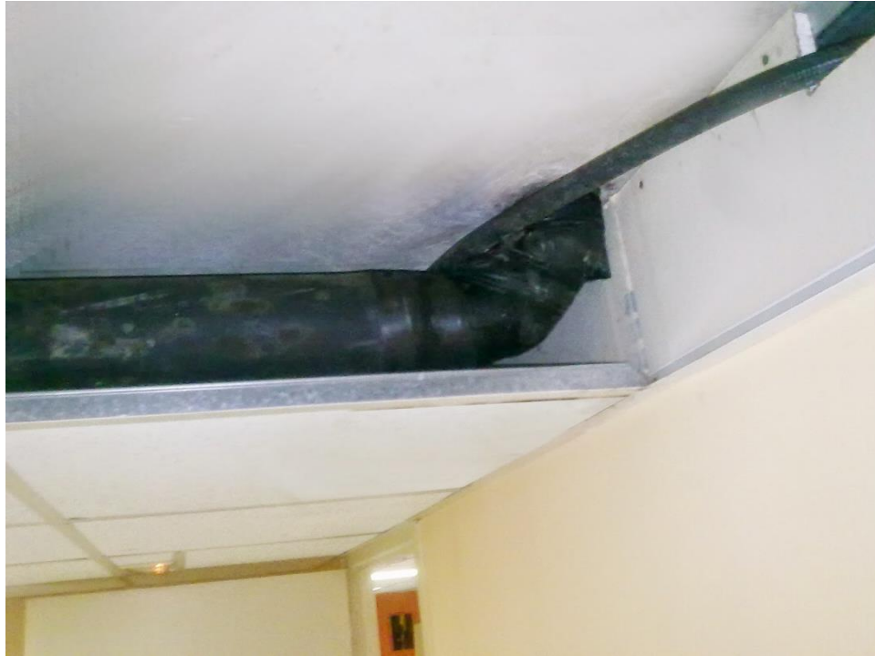
Oblaganje cevi zvučnom izolacijom AIT PR 3.5
