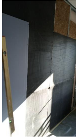
Postavljanje Vidiwall ploča
