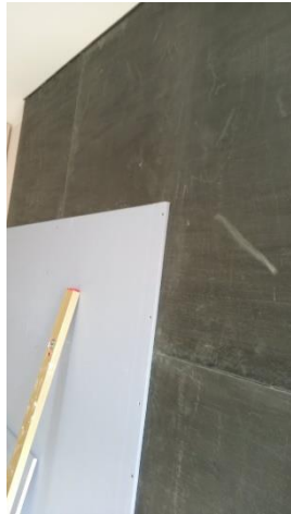
Postavljanje Vidiwall ploča
