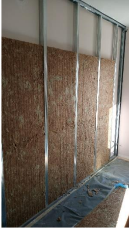
Postavljanje konstrukcije i vune
