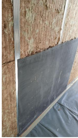
Postavljanje zvučne membrane
