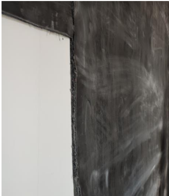
Slika br. 2 - Izgled zida obloženog membranom AIT PR 3.5
