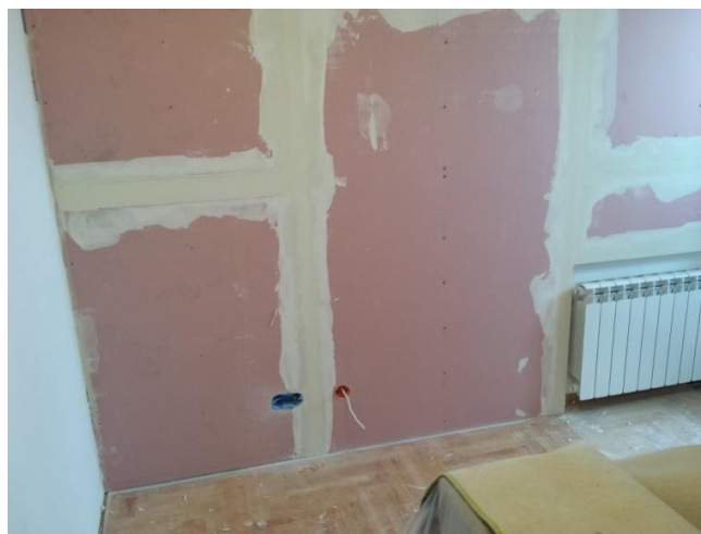
Slika br.4-Postavljanje drugog sloja ploča i obrada spojeva
