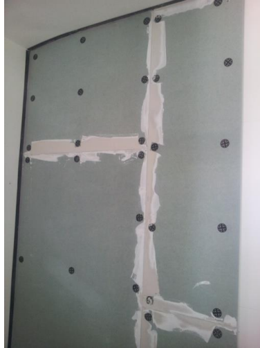
Slika br. 3 – Vidiwall ploče tiplovane u zid preko izolacije PR 3.5
