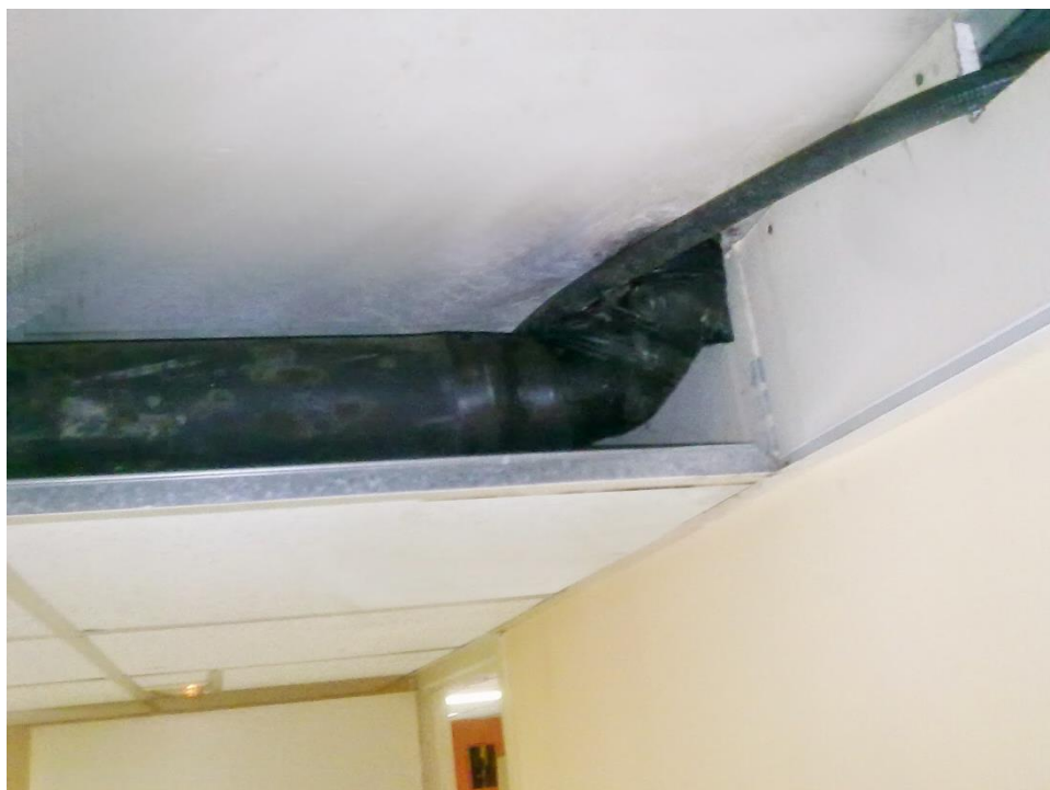
Oblaganje cevi zvučnom izolacijom AIT PR 3.5
