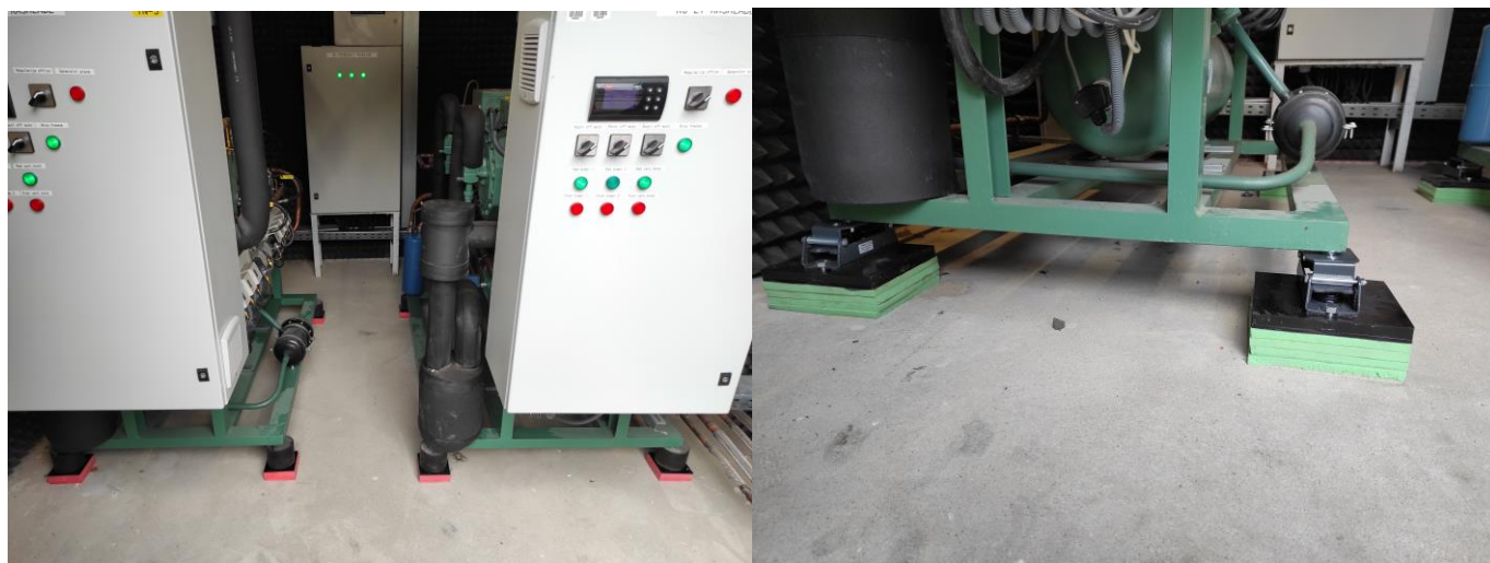
Primena Sylomera i Sylodina u rešenjima zaštite od vibracija uređaja i opreme
