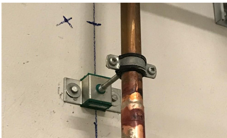
Primena elastične spojnice EP + Sylomer
