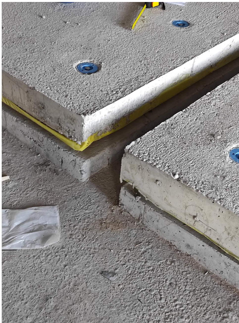
Izgled plivajućeg poda po završenoj montaži opruga
