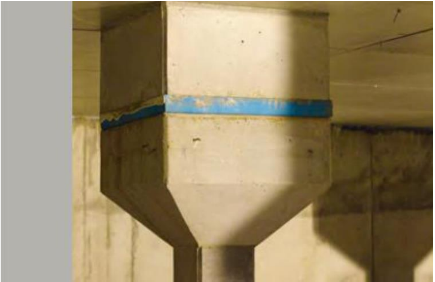
Primer tačkastog strukturnog odvajanja pomoću Sylodina
