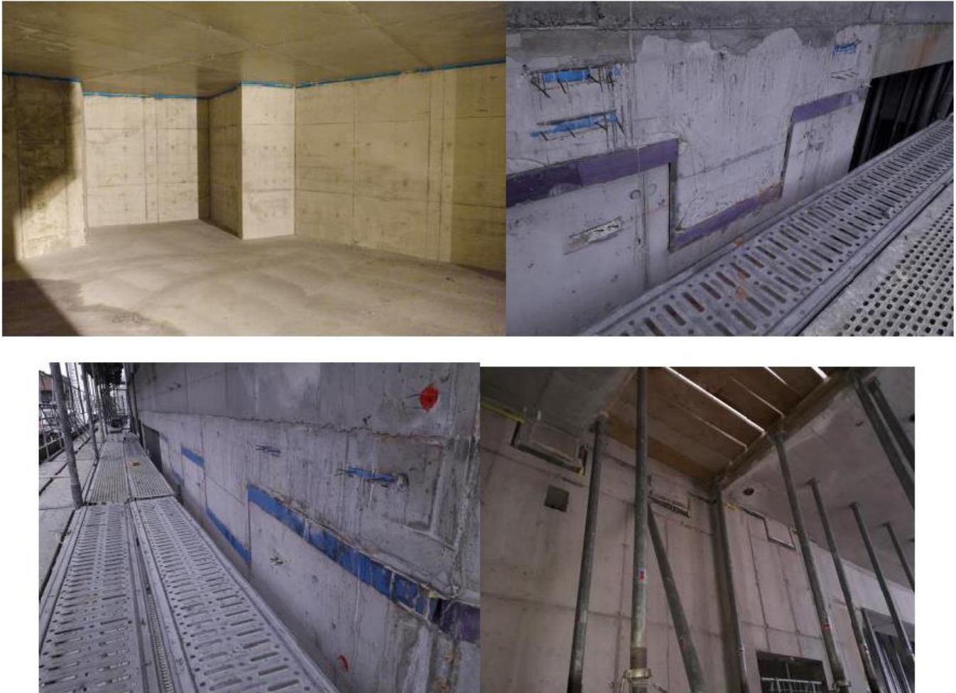
Principi tačkastog i trakastog elastičnog odvajanja objekta
