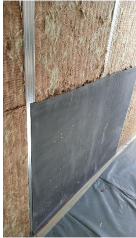
Postavljanje zvučne membrane
