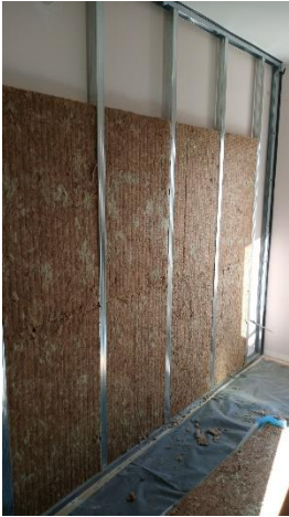
Postavljanje konstrukcije i vune membrane
