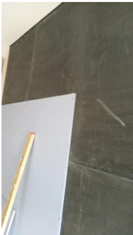
Postavljanje panela ZIPS dB
