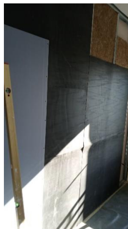
Postavljanje panela ZIPS dB
