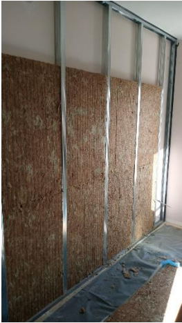
Postavljanje konstrukcije i vune
