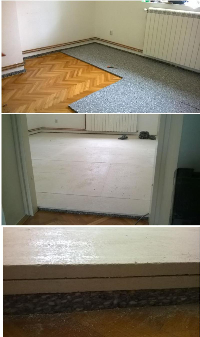
*Presek akustičkog poda koji se sastoji od materijala Audiotek PO 120 debljine 20mm i dve Knauf Vidifloor ploče debljine 2 x 12.5mm - Ukupna debljina poda 45mm bez završnog sloja*
