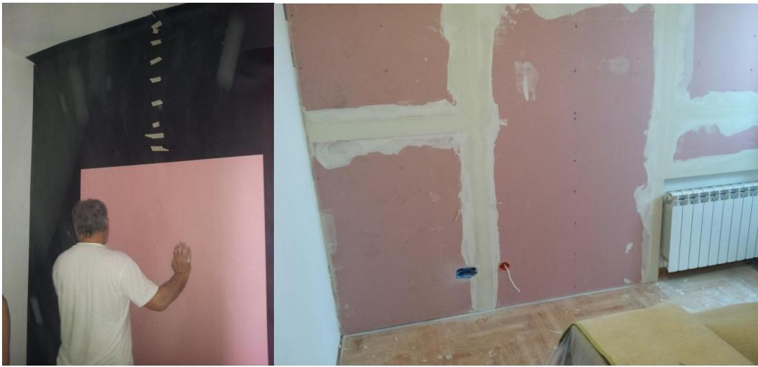
Slika br. 4-Postavljanje drugog sloja ploča i obrada spojeva
