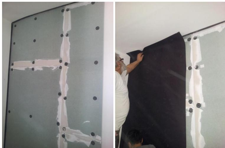
Slika br.3-Obrada spojeva i postavljanje viskoelastičnog medjusloja
